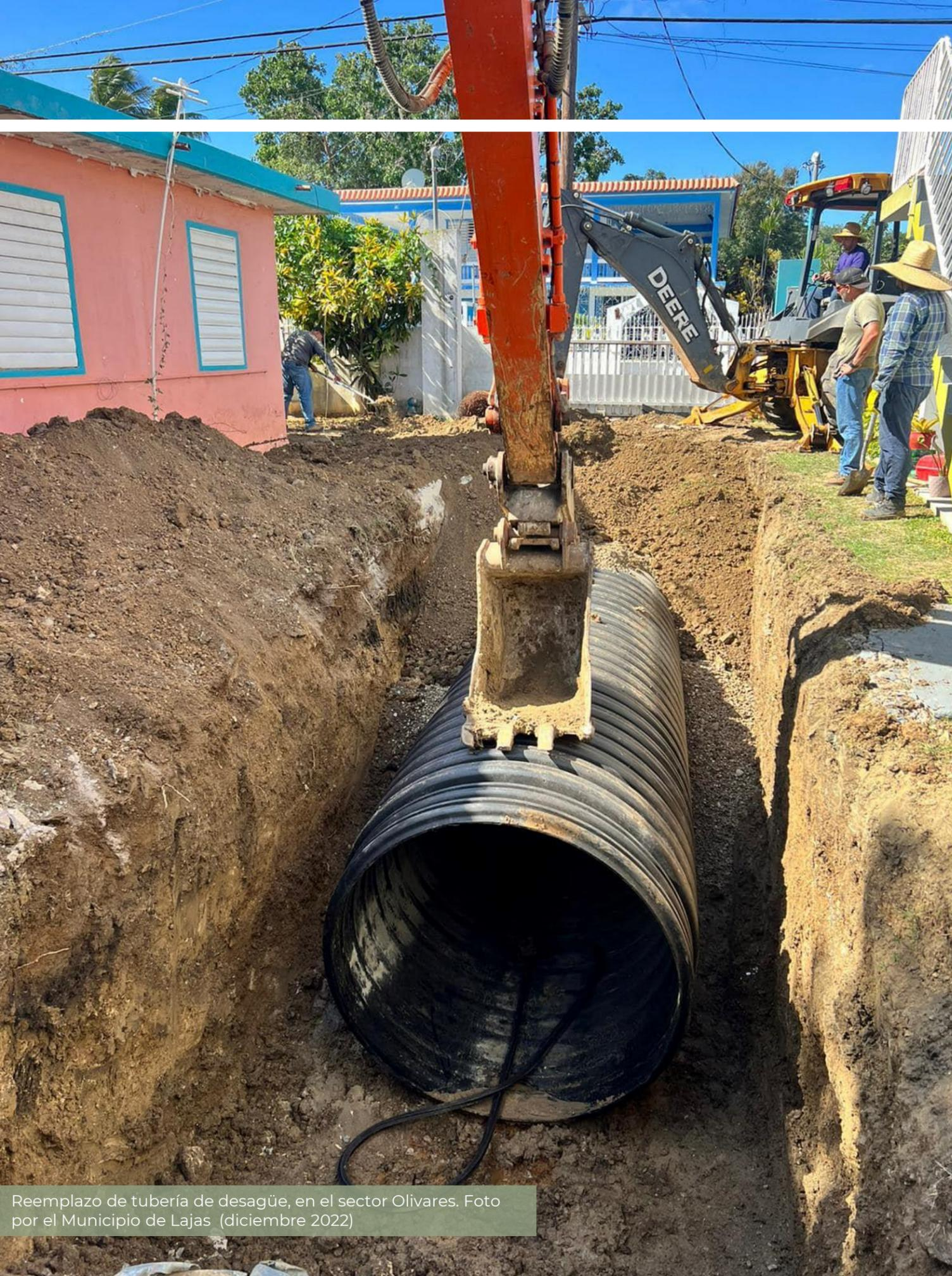
Reemplazo de tubería de desagüe, en el sector Olivares. Foto por el Municipio de Lajas (diciembre 2022)
