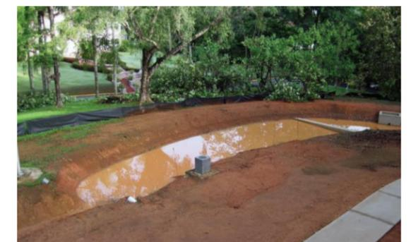
Estanque para captura de sedimentos y sistema pluvial del IITF en el Jardín Botánico de Río Piedras<sup>1</sup>
