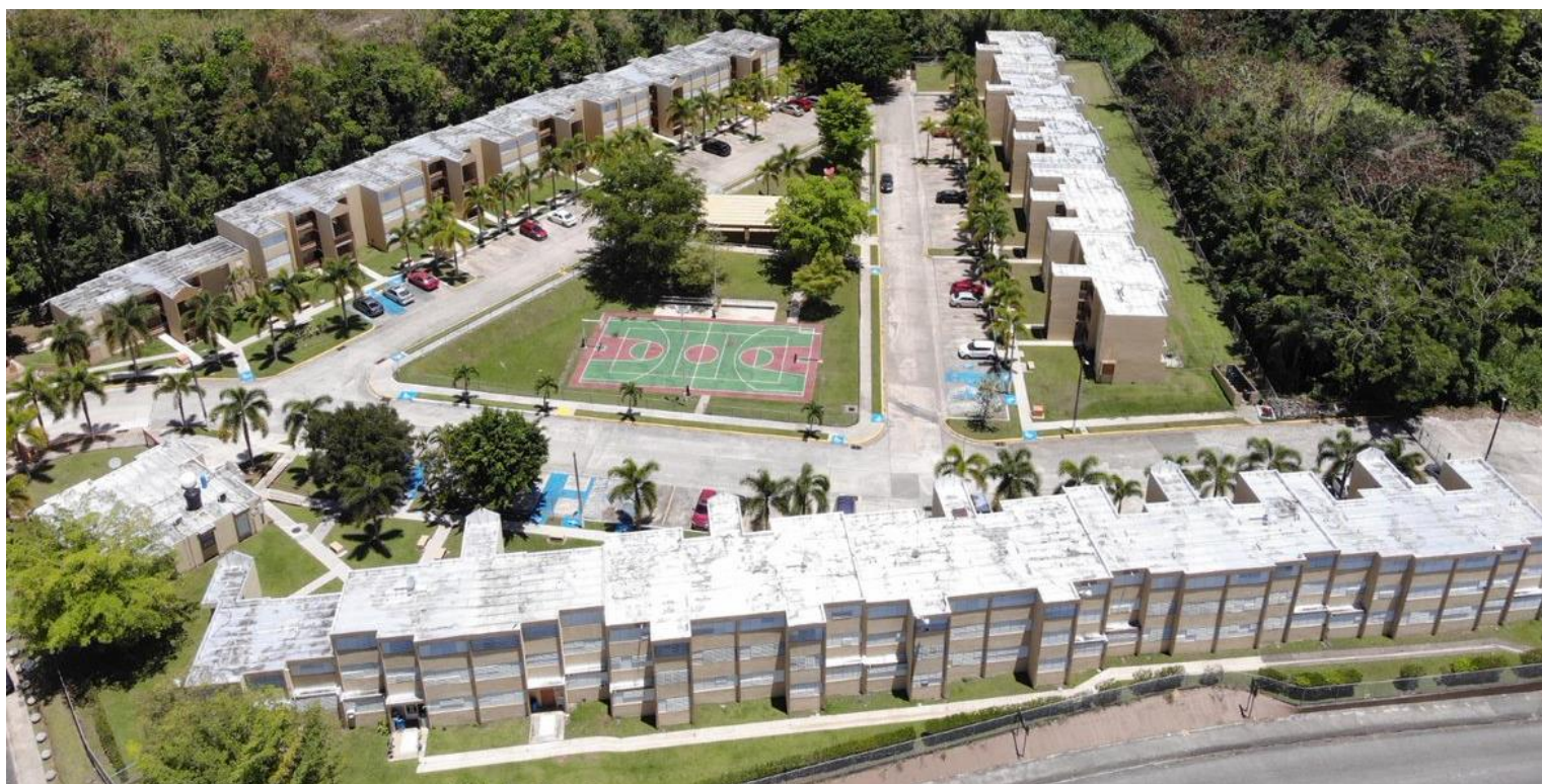
Complejo de vivienda multifamiliar en el barrio Monte Llano. Foto por CMA (abril 2023)
