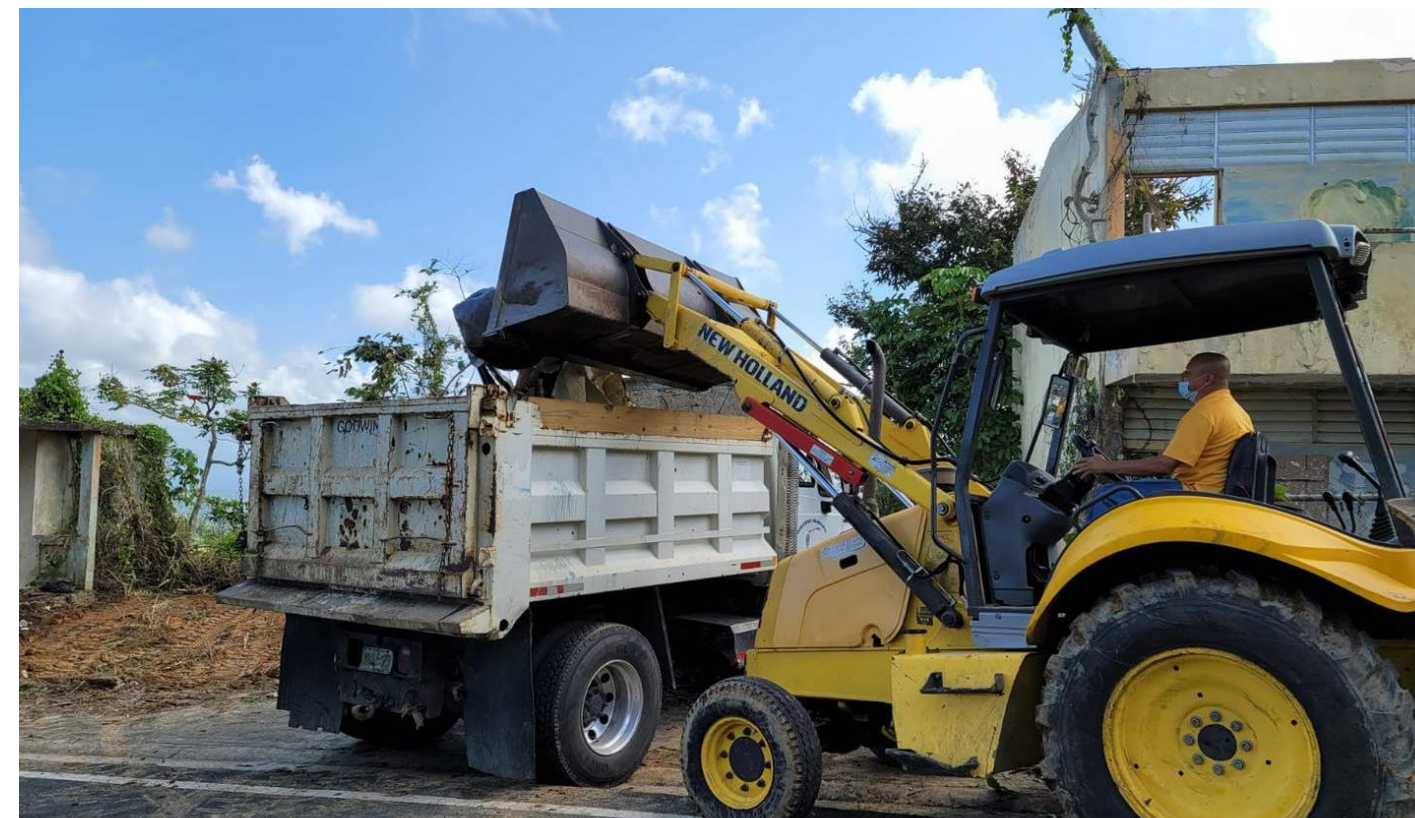
Personal municipal utilizando maquinaria para el recogido de escombros frente a la escuela. Foto de la página de Facebook del Municipio de Morovis (marzo 2021)
