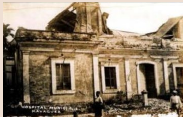
Dstrucción del Hospital Municipal de Mayagüez (Terremoto de 1918) Foto: Puerto Rico Urbano, Vol. 4.
