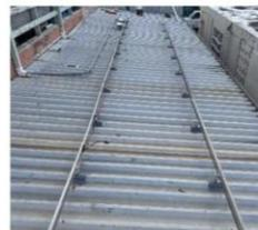
Estructura de montaje
